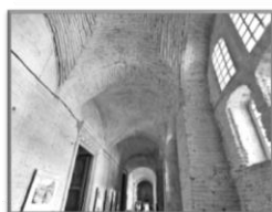
Figura 06. Nártex externo Coberturas em abóbodas de arestas feitas em pedras.
